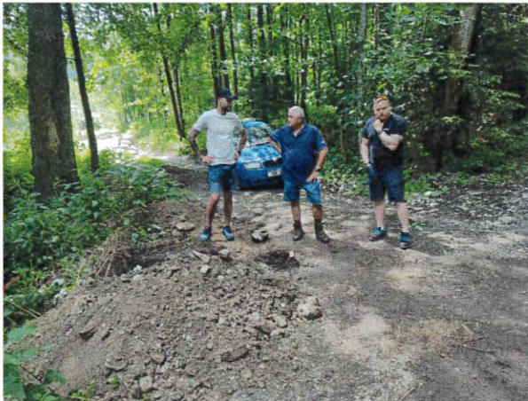
sonda pod křížením potoka, pohled od VDJ
