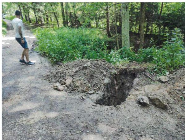
sonda pod křížením potoka, pohled k VDJ
