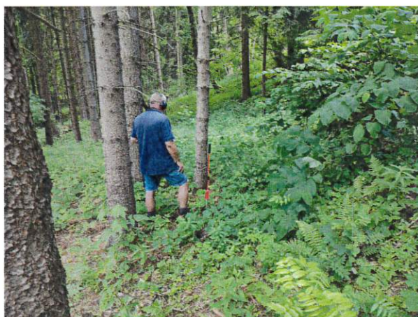
hledání skutečné staré trasy akustic. hledačkou (provádí správce vodovodu)
