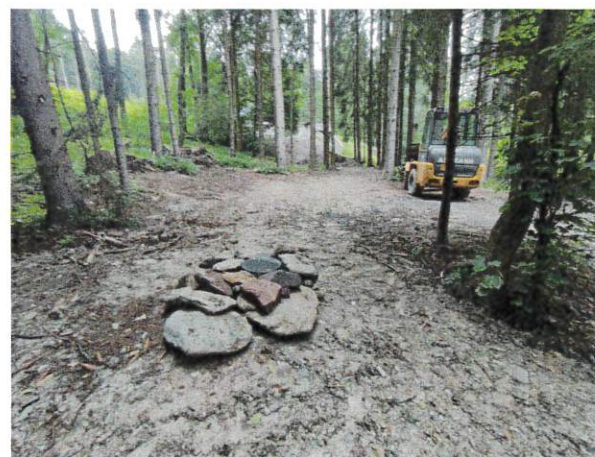
detail vzdušníku, v lese proveden obklad kamenem (posunutí nad cestu, na obecní parcelu 1025)
