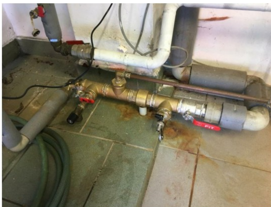
Opravené potrubí studené vody
