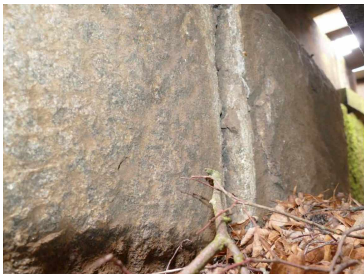
Závěrná zed' O 01: Ve střední části vysunutý 1 kámen až o 30 mm
