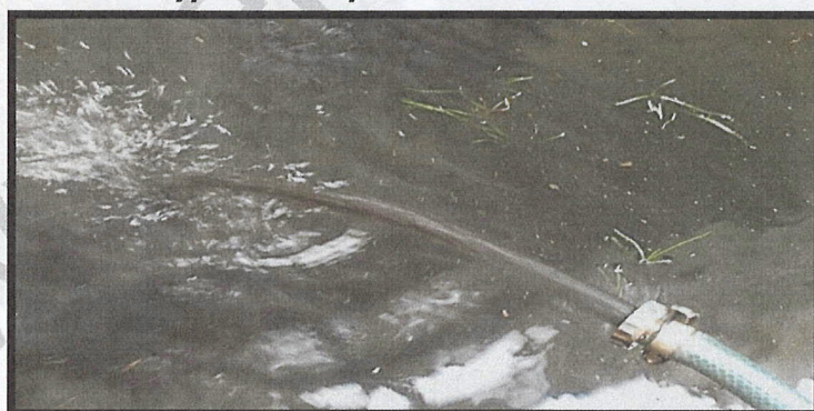
Vypuštění rozpuštěného nánosů z ÚT:
