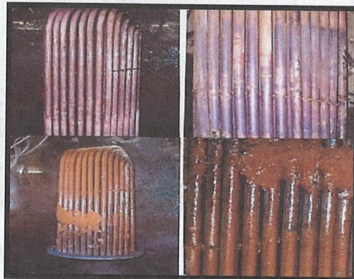
Těleso v bojleru po čištění:
