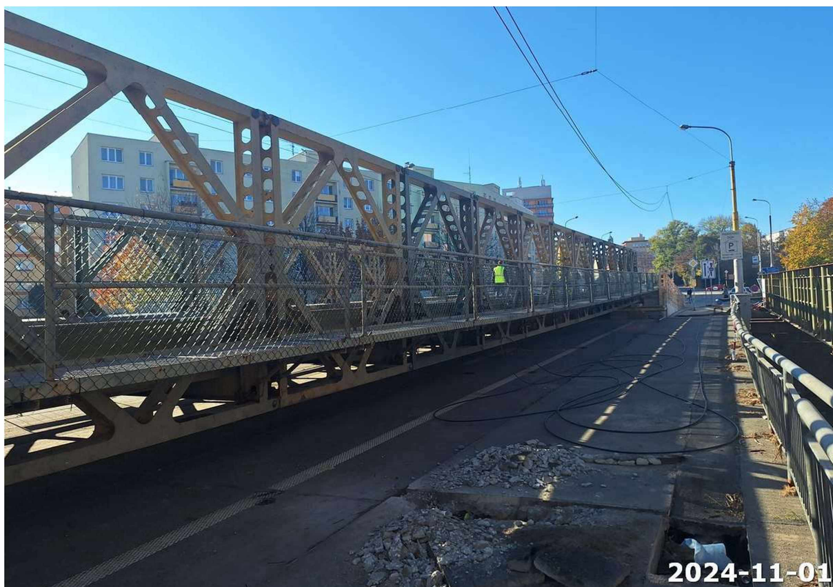
Obr. 14 – Pohled na pravý příhradový nosník ze strany opěry 02
