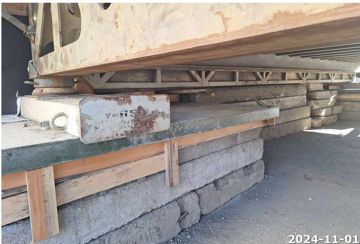
Obr. 8 – Úložný blok na straně opěry 02
