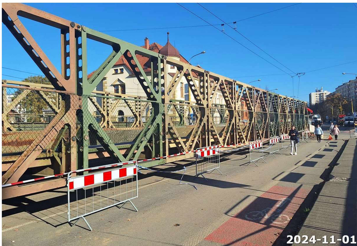
Obr. 13 – Pohled na levý příhradový nosník ze strany opěry 01
