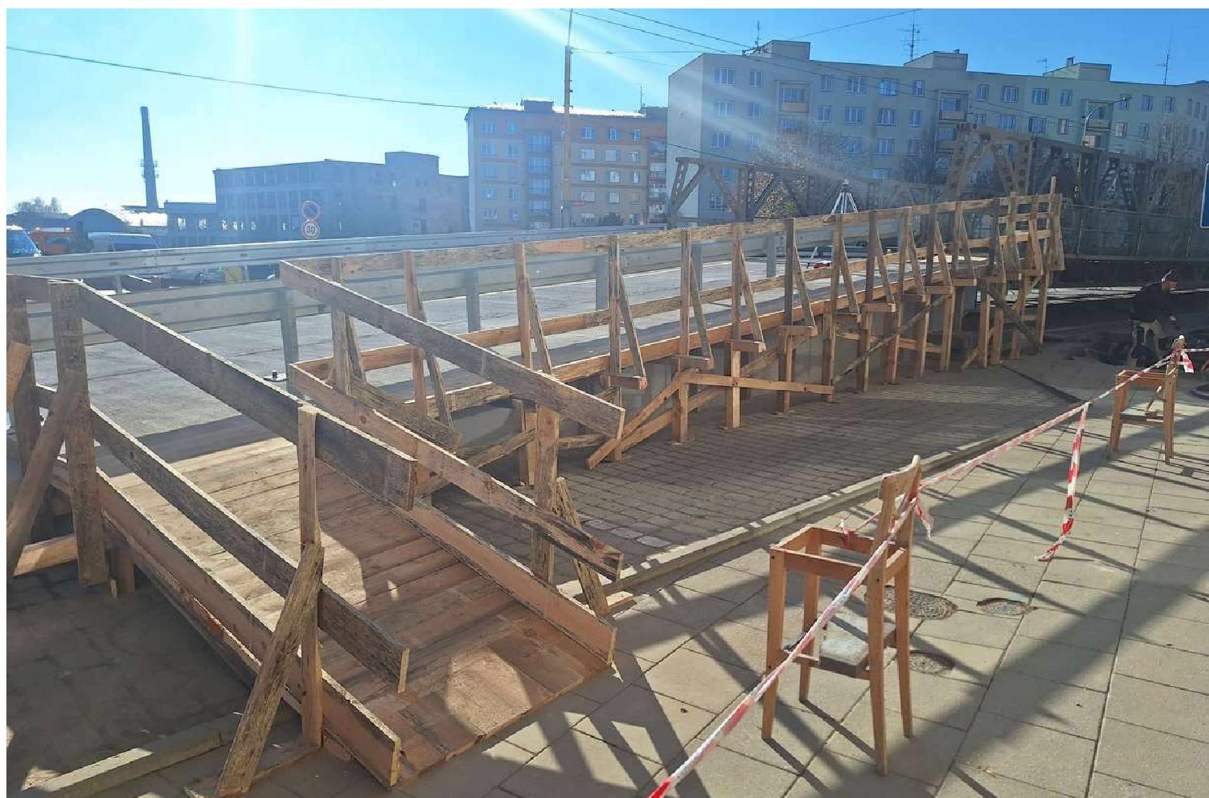
Obr. 6 – Chodníková rampa se zábradlím na straně opěry 02
