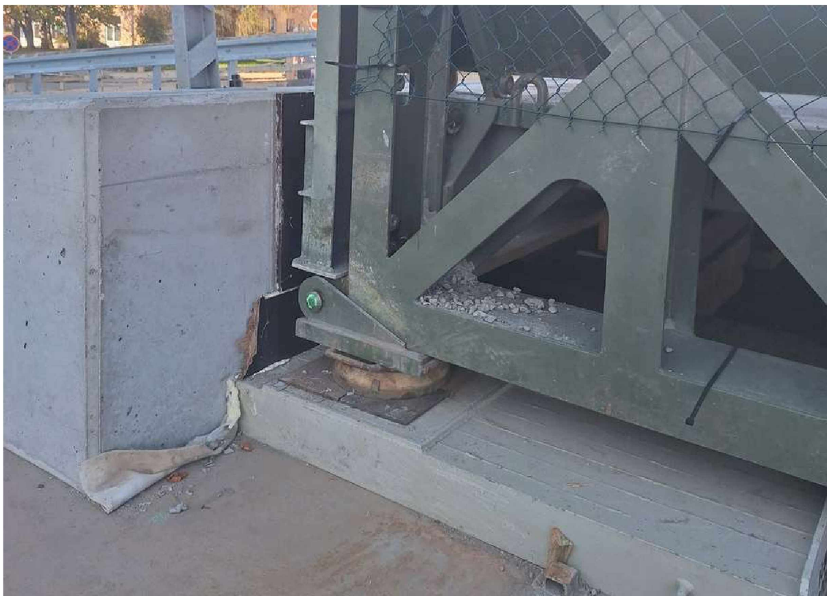
Obr. 7 – Detail uložení pravého příhradového pásu na straně opěry 01
