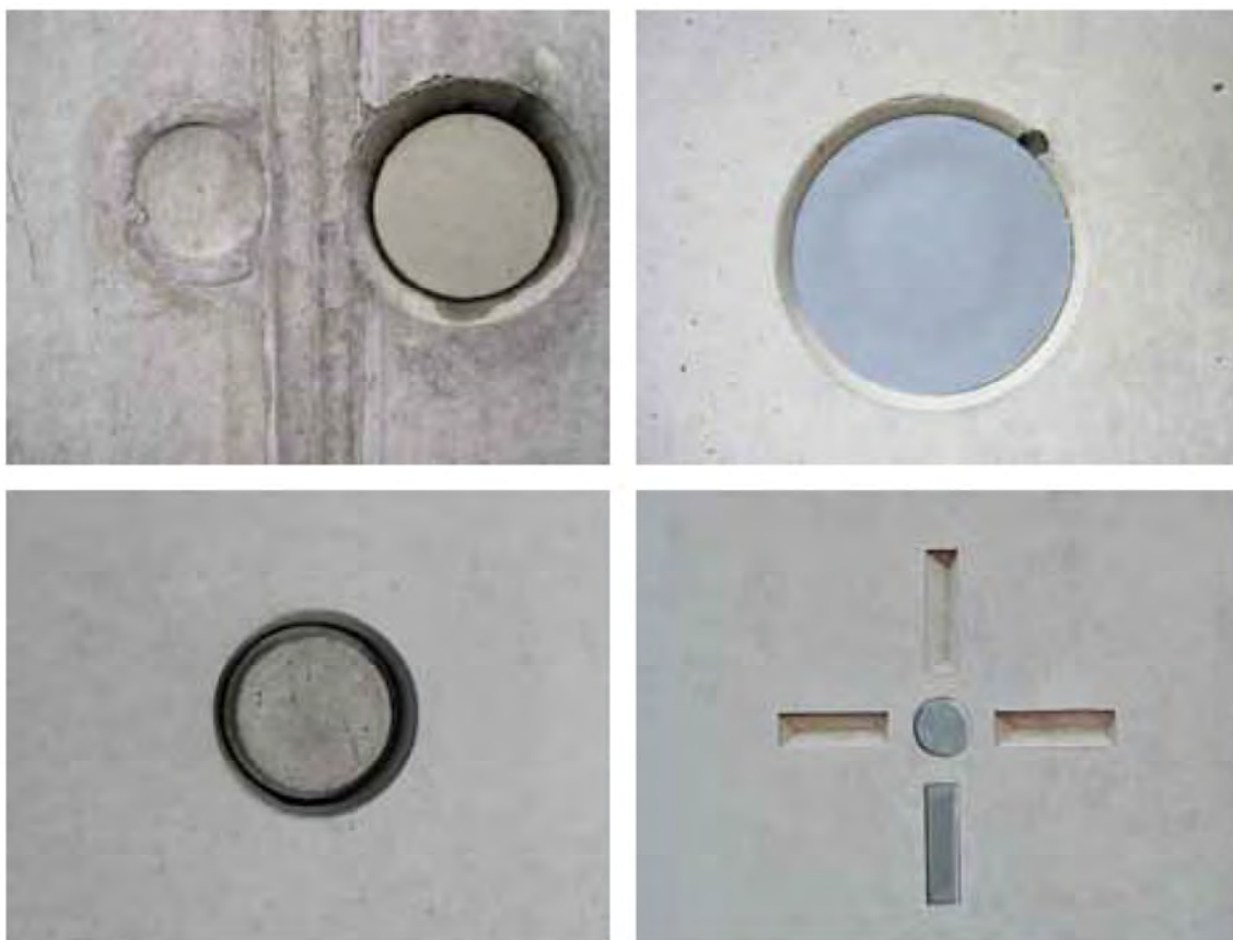
(23) Obr. F.2 – Různé způsoby uzavření spínacích otvorů
