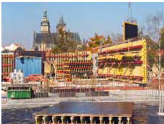
(25) Obr. F.4 – Nosníkové bednění
