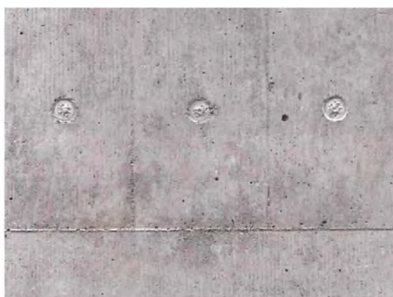
b) z pohledové strany u nosíkového nebo atypického bednění (vlevo bednění / vpravo povrch betonu)
