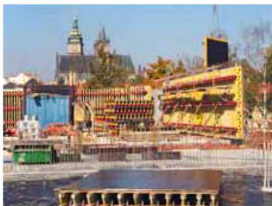
(25) Obr. F.4 – Nosníkové bednění
