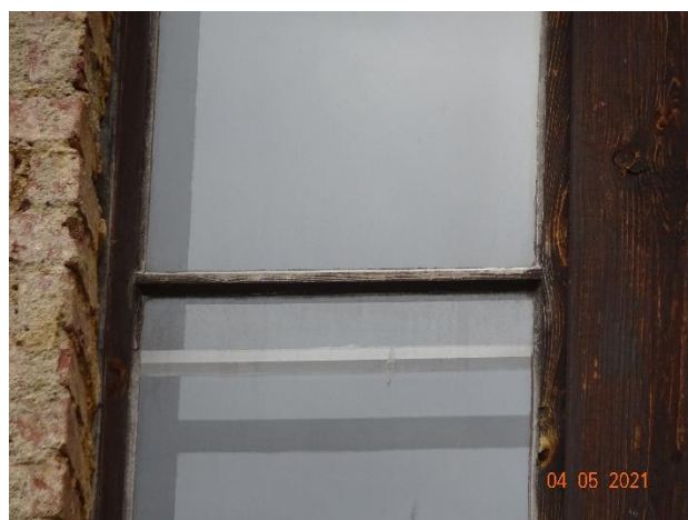
Obr. 41 a 42 –detail profilace okenního rámu vč. poutce na schodišťovém okně (ozn. 14)
