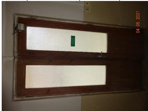
Obr. 37 a 38 – detailní pohled z exteriéru/interiéru na částečně prosklené dřevěné dvoukřídlé dveře (ozn. 204) určené k výměně
