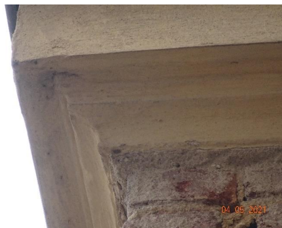
Obr. 31 a 32 – detail profilace dochované kordonové římsy mezi 1. a 2. NP na boční straně jižní fasády
