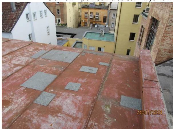
Obr. 62 a 63 – viditelné provizorní opravy střešní krytiny z falcovaného plechu nad hlavním schodištěm
