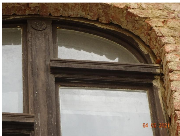
Obr. 18 –detail profilace okenního rámu vč. poutců na schodišťovém okně (ozn. 22)
