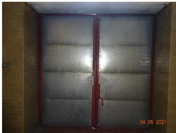
Obr. 48 a 49 – detailní pohled z exteriéru a interiéru na vrata do mycího boxu (ozn. 205) určená k výměně
