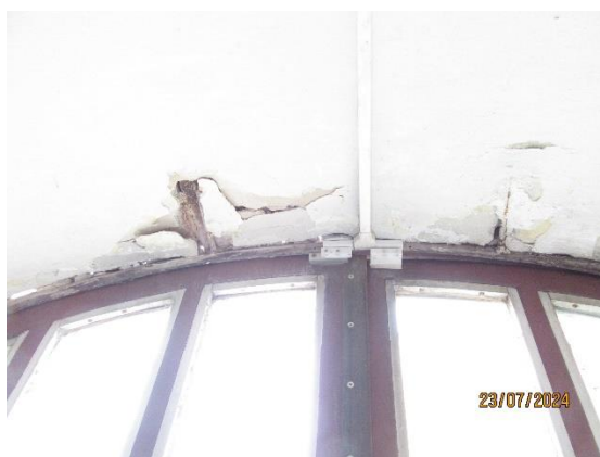
Obr. 75 až 79 – odlupující se části maleb a omítek
