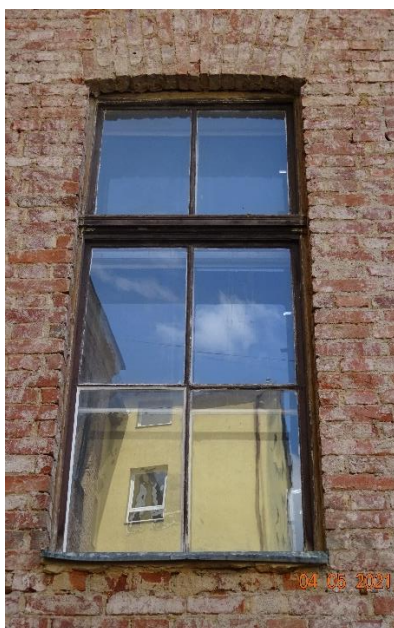
Obr. 9, 10 a 11 – detailní pohled na dvojité schodišťová okna (ozn. 24, 23 a 20) určená k repasi
