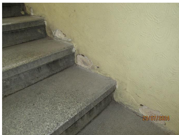
Obr. 88 a 91 – Nesoudržné a zvětralé části omítek a maleb na stěnách a sloupech
