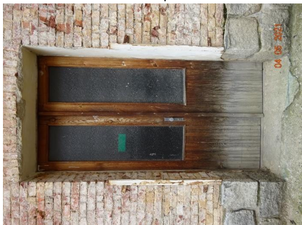
Obr. 37 a 38 – detailní pohled z exteriéru/interiéru na částečně prosklené dřevěné dvoukřídlé dveře (ozn. 204) určené k výměně
