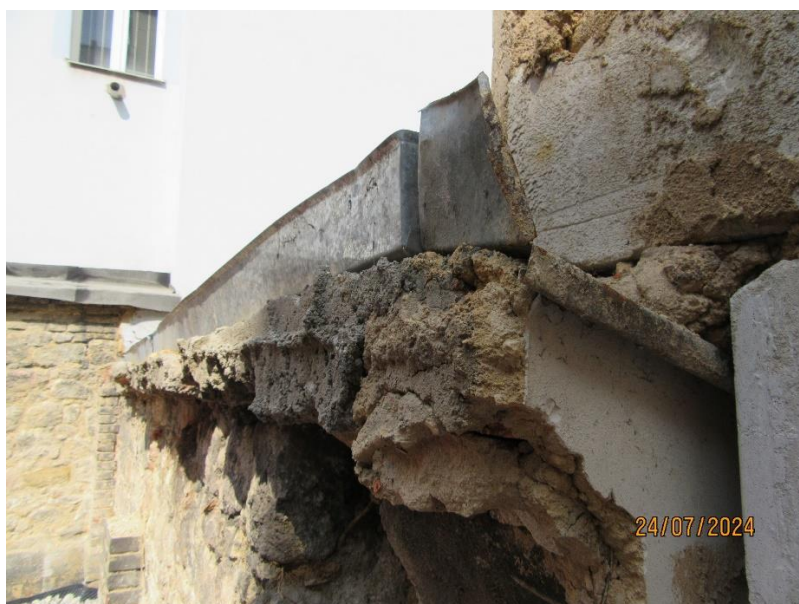
Obr. 68 až 71 – detaily neupravené opěrné zídky s ozn. OZ2
