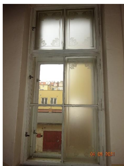
Obr. 13 a 14 – detailní pohled z interiéru na dvojité schodišťová okna (ozn. 22 a 23) určená k repasi
