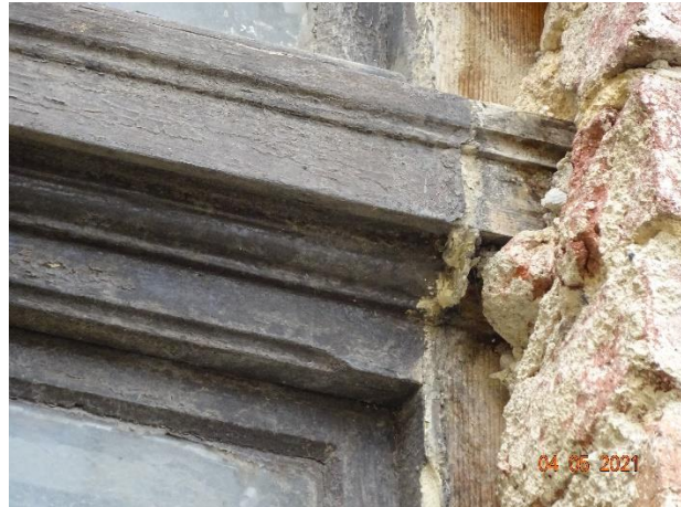
Obr. 20 –detail profilace okenního rámu vč. poutců na schodišťovém okně (ozn. 24)
