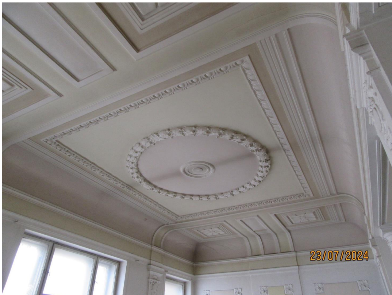
Obr. 85 – Plastický strop se štukatérskou výzdobou nad hlavním schodišťovým prostorem
