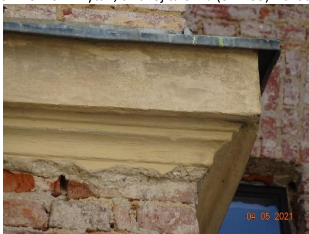
Obr. 4 – detail profilace dochované kordonové římsy mezi 1. a 2. NP jižní fasády
