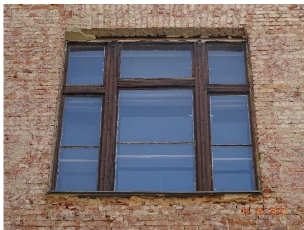
Obr. 7 a 8 – detailní pohled na dvojité schodišťová okna (ozn. 22 a 21) určená k repasi
