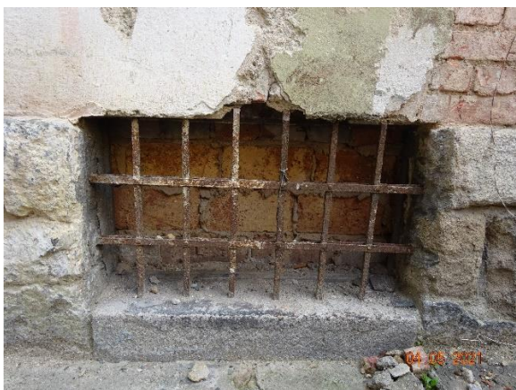
Obr. 25 a 26 – dodatečně vytvořený suterénní okenní otvor, který není zakreslen v původní předkládané dokumentaci a stávající okenní otvor (ozn. 25)
