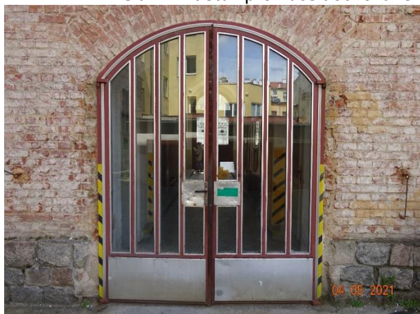
Obr. 5 a 6 – detailní pohled z exteriéru/interiéru na částečně prosklená dvoukřídlá vrata z průjezdu s kovovou konstrukcí (ozn. 203) určená k výměně
