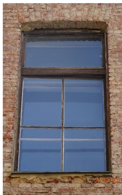
Obr. 9, 10 a 11 – detailní pohled na dvojité schodišťová okna (ozn. 24, 23 a 20) určená k repasi
