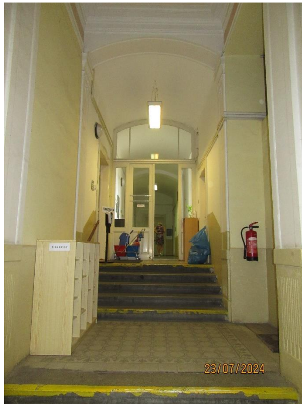
Obr. 81 – navazující část chodby z průjezdu směrem do východního křídla (výmalba se týká části až k prosklené stěně)
