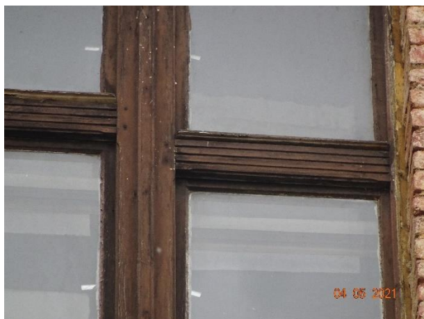
Obr. 19 –detail profilace okenního rámu vč. poutců na schodišťovém okně (ozn. 21)
