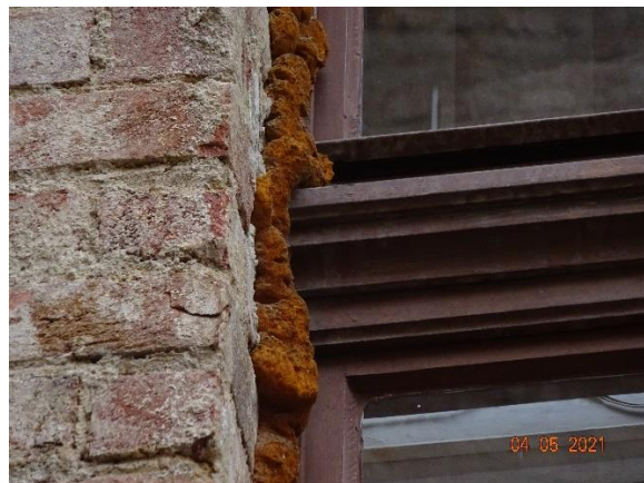
Obr. 27 a 28 – detail profilace okenního rámu vč. poutců na kancelářském okně (ozn. 33)
