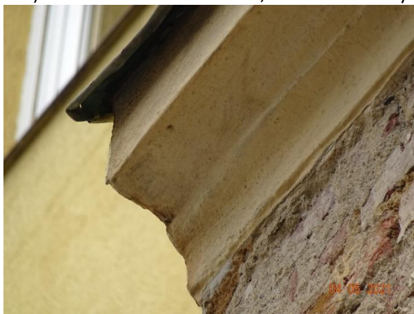
Obr. 36 – detail profilace dochované kordonové římsy mezi 1. a 2. NP východní fasády
