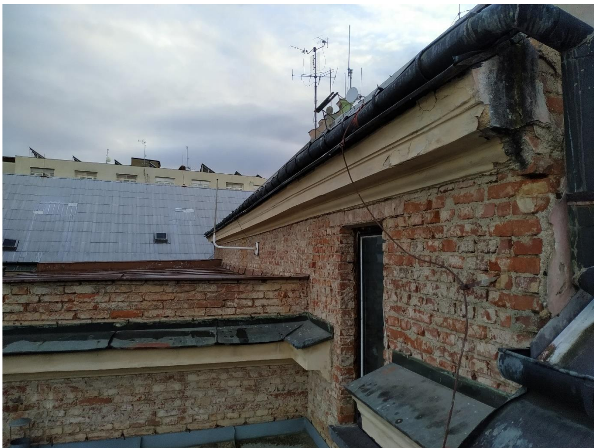
Obr. 21 – Pohled A: výstup z půdního prostoru ocelovými dveřmi (ozn. 201) na plochou střechu nad schodišťovým prostorem jižní části fasády
