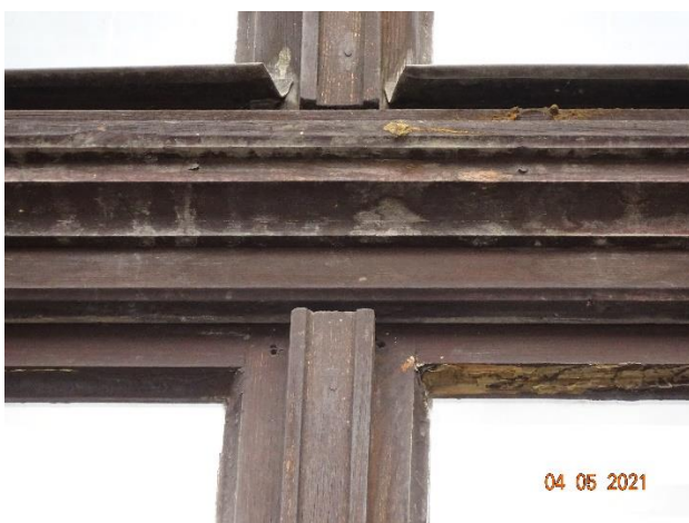
Obr. 43 a 44 –detail profilace okenního poutce vč. okapnic na okenních křídlech na schodišťovém okně (ozn. 33)
