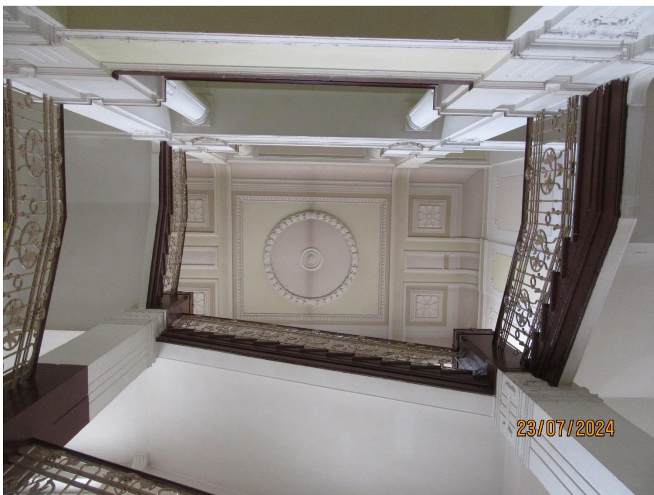
Obr. 82 až 84 – Hlavní schodišťový prostor (tříramenné schodiště s mezipodestami)
