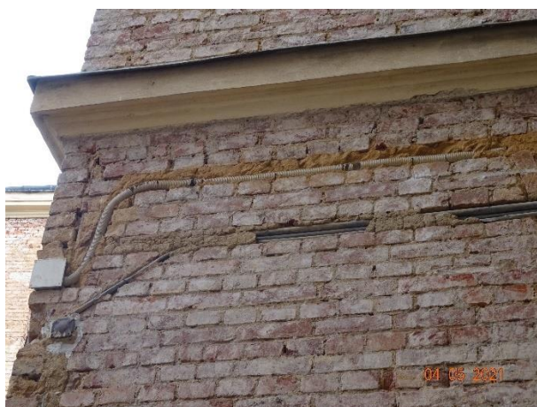
Obr. 31 a 32 – detail profilace dochované kordonové římsy mezi 1. a 2. NP na boční straně jižní fasády
