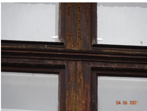
Obr. 41 a 42 –detail profilace okenního rámu vč. poutce na schodišťovém okně (ozn. 14)
