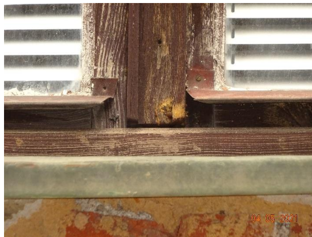
Obr. 43 a 44 –detail profilace okenního poutce vč. okapnic na okenních křídlech na schodišťovém okně (ozn. 33)
