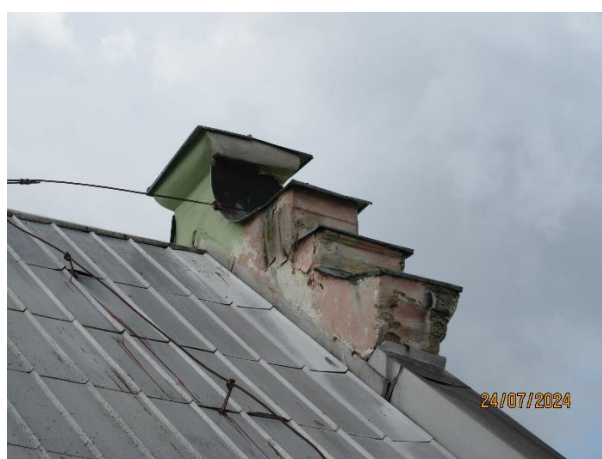
Obr. 57 a 58 – pohled na zdobené štíty mezi sedlovými střechami hlavního jižního křídla, opravy se týkají neopravených částí směrem do dvora
