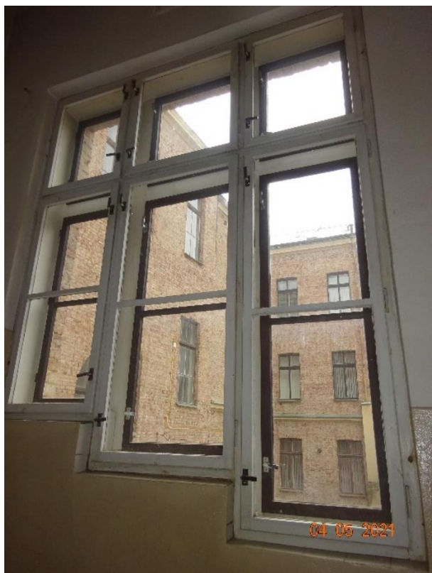
Obr. 45 – detail dvojitého schodišťového okna (ozn. 14) z interiéru
