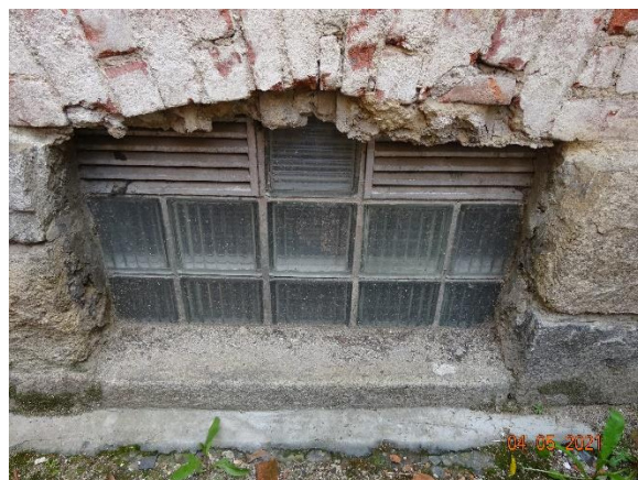
Obr. 25 a 26 – dodatečně vytvořený suterénní okenní otvor, který není zakreslen v původní předkládané dokumentaci a stávající okenní otvor (ozn. 25)
