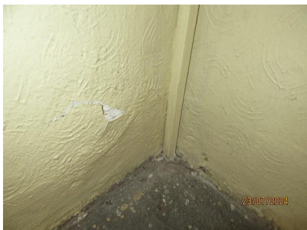
Obr. 88 a 91 – Nesoudržné a zvětralé části omítek a maleb na stěnách a sloupech
