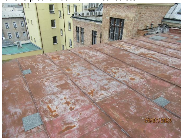
Obr. 62 a 63 – viditelné provizorní opravy střešní krytiny z falcovaného plechu nad hlavním schodištěm
