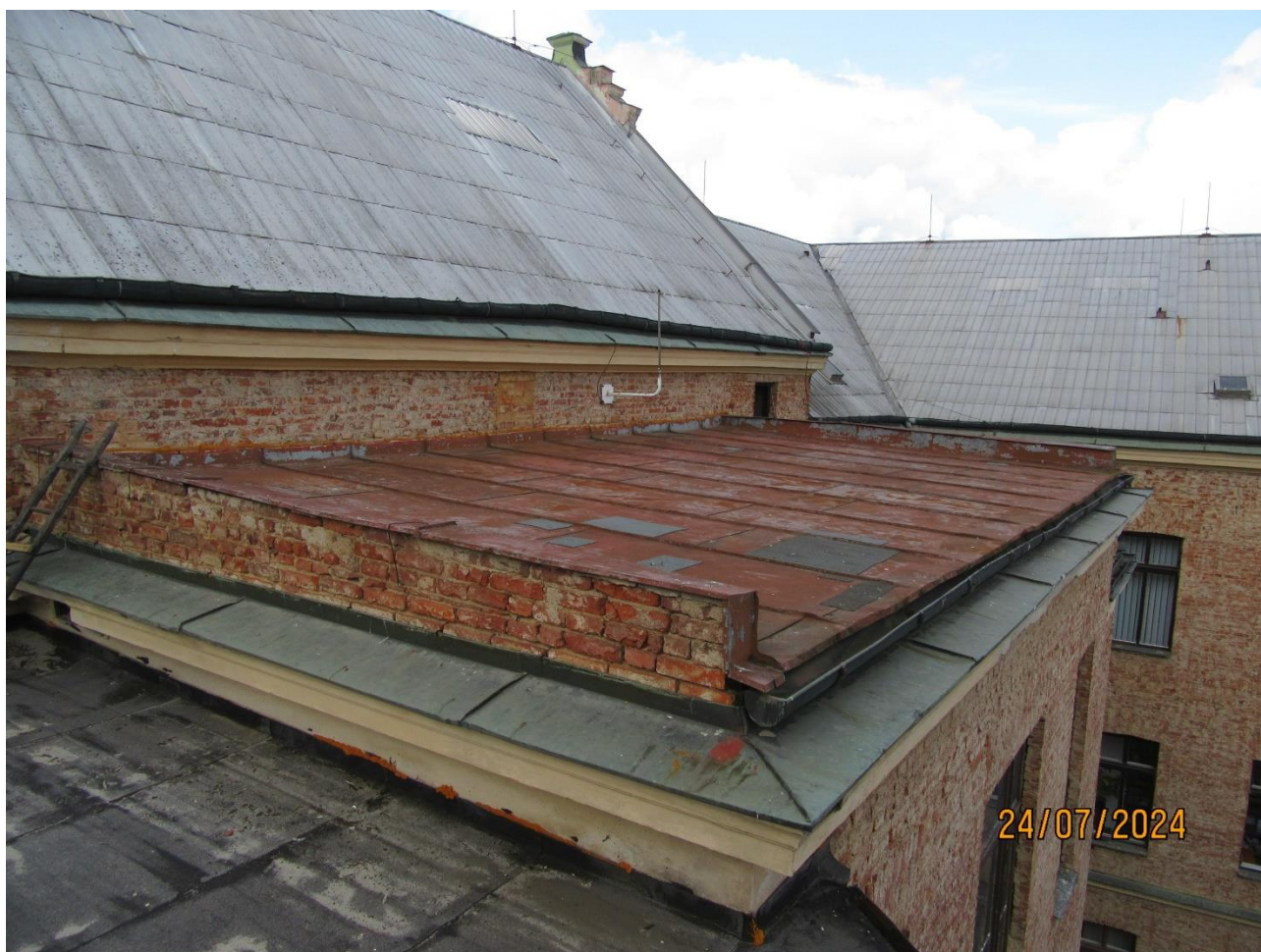
Obr. 61 – pohled na střešní krytinu z falcovaného plechu nad hlavním schodištěm
