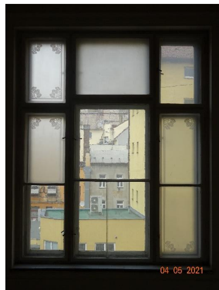
Obr. 16 – detail dvojitého schodišť. okna (ozn. 21) z interiéru
