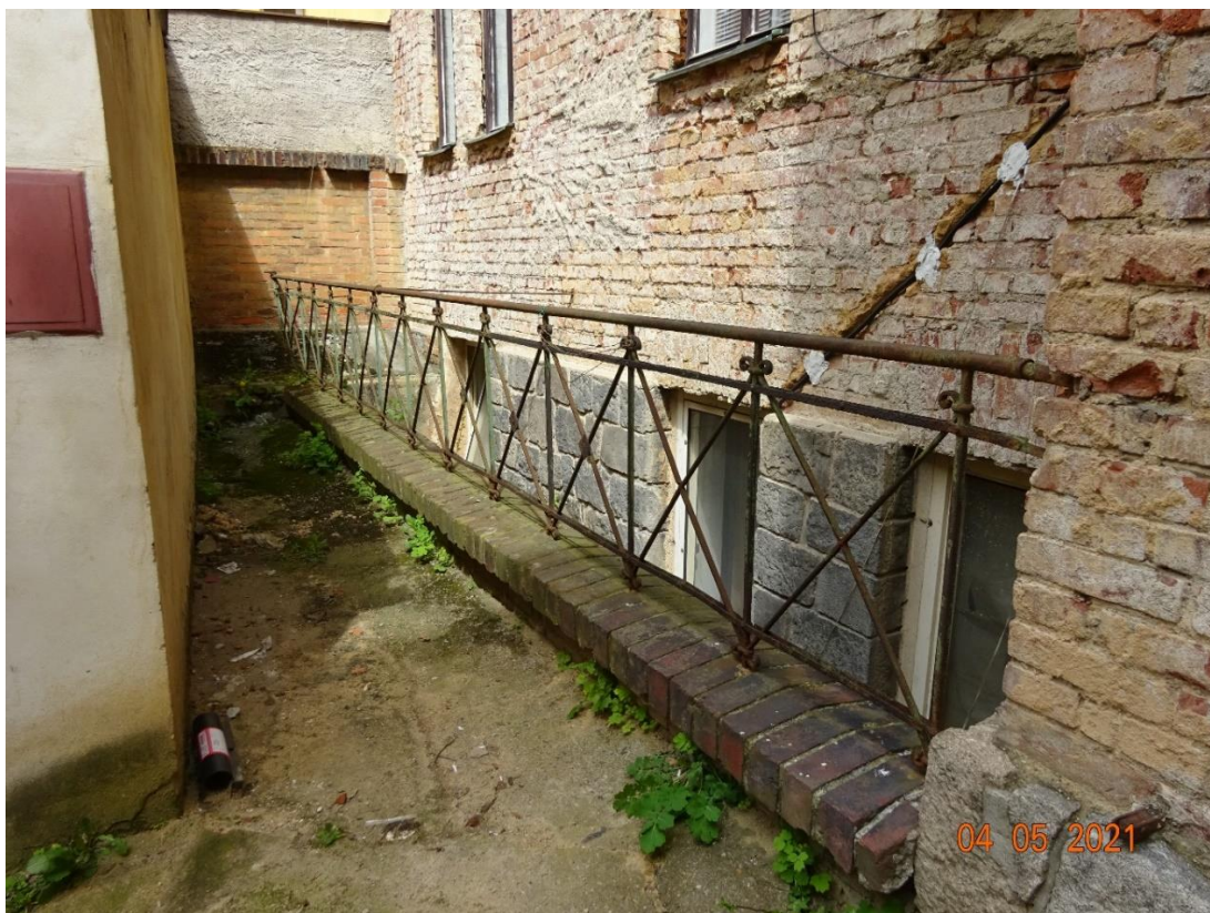
Obr. 35 – Pohled D: fasáda východního křídla, anglický dvorek se třemi jednoduchými jednokřídlými okny (ozn. 12) v úrovni kamenného soklu, okna určená k výměně
