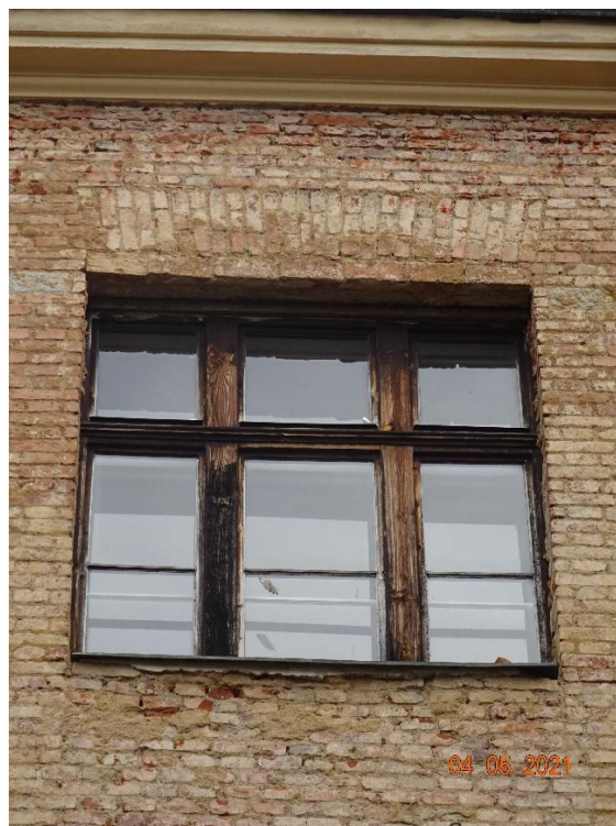
Obr. 39 a 40 – detailní pohled na dvojité schodišťové okna (ozn. 14 a 13) určená k výměně
