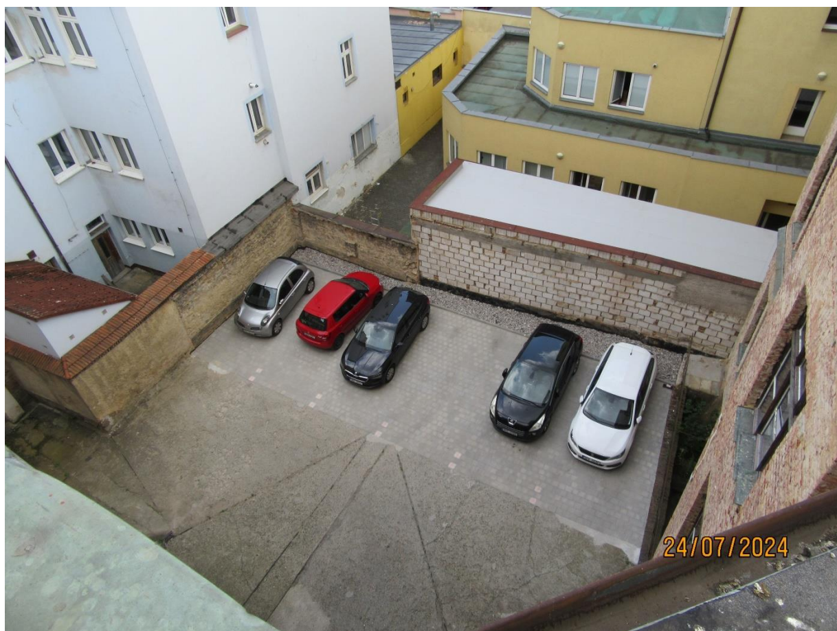
Obr. 64 – pohled do vnitrobloku na nové parkovací stání po odstraněných řadových garážích
