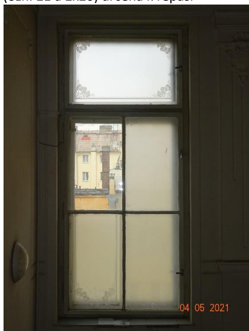
Obr. 17 –detail dvojitého schodišťového okna (ozn. 20) z interiéru
