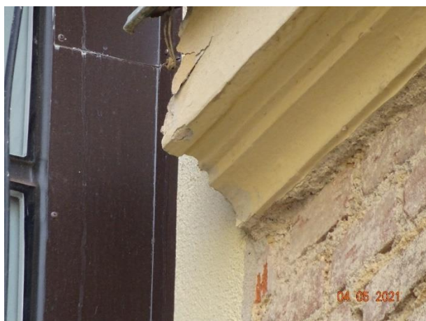
Obr. 29 – detail profilace dochované kordonové římsy mezi 1. a 2. NP západní fasády
