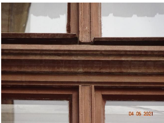
Obr. 27 a 28 – detail profilace okenního rámu vč. poutců na kancelářském okně (ozn. 33)
