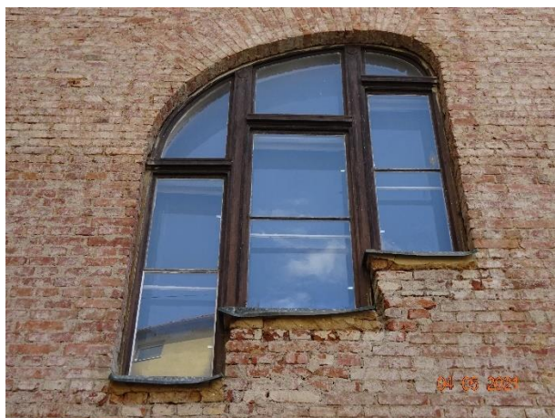
Obr. 7 a 8 – detailní pohled na dvojité schodišťová okna (ozn. 22 a 21) určená k repasi
