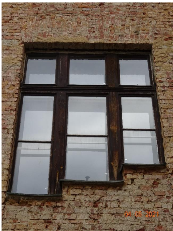
Obr. 39 a 40 – detailní pohled na dvojité schodišťové okna (ozn. 14 a 13) určená k výměně
