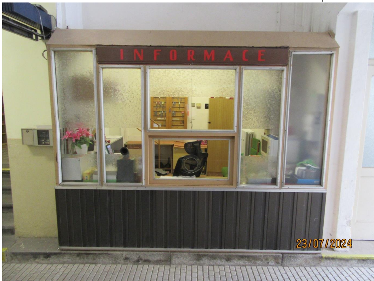
Obr. 92 – Stávající vrátnice v místě průjezdu a hlavního schodišťového prostoru
