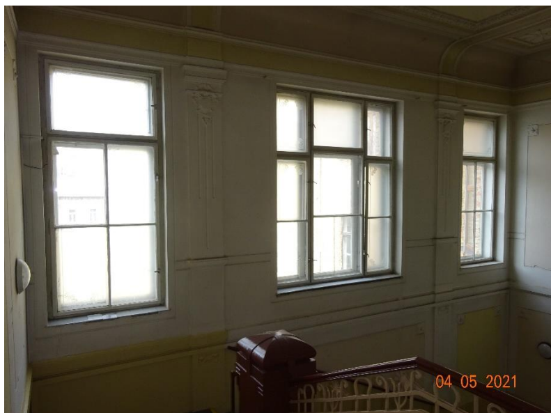
Obr. 15 – pohled z interiéru na dvojité schodišťová okna (ozn. 21 a 2x20) určená k repasi
