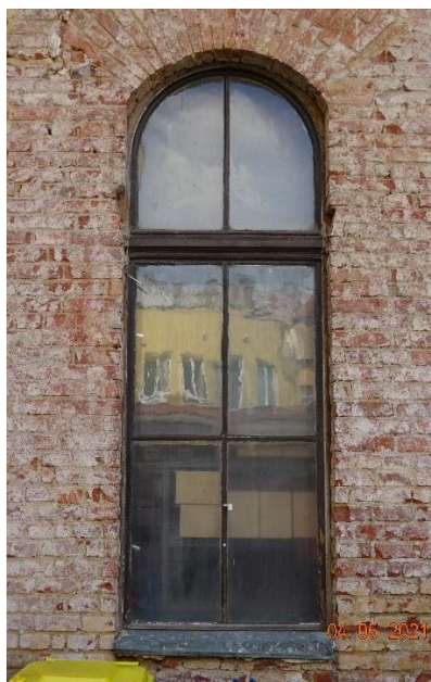
Obr. 9, 10 a 11 – detailní pohled na dvojité schodišťová okna (ozn. 24, 23 a 20) určená k repasi
