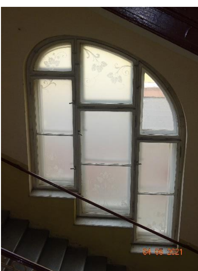
Obr. 13 a 14 – detailní pohled z interiéru na dvojité schodišťová okna (ozn. 22 a 23) určená k repasi
