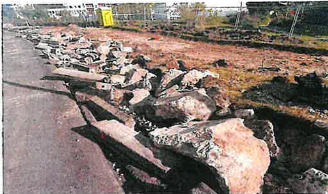
Bourání betonové desky v chodníku v tl. 100 - 120 mm
