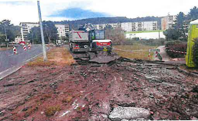
Bourání betonové desky v chodníku v tl. 100 - 120 mm
