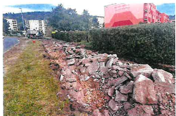
Borání patek u sadových obrub ST 0,00 km - 0,400 km
