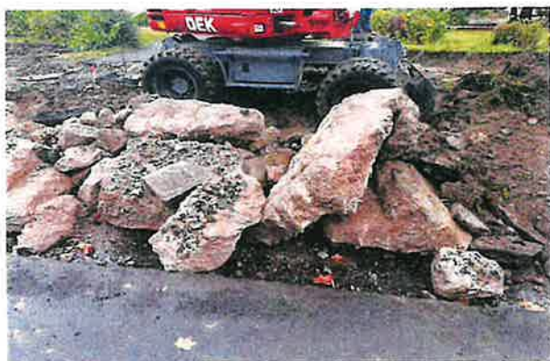
Borání patek u sadových obrub ST 0,00 km - 0,400 km
